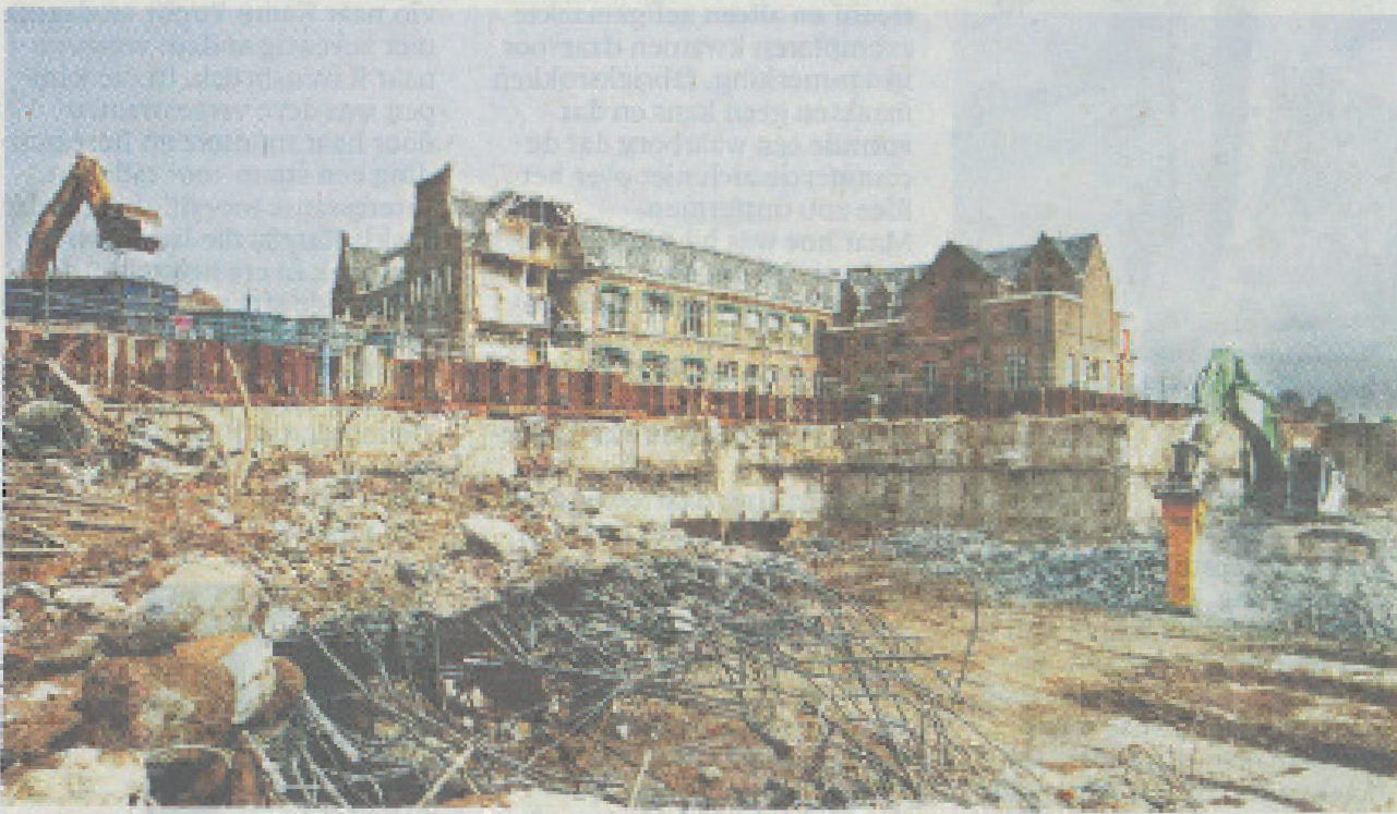
Op een diepte van negen meter zijn machines bezig om de twee meter dikke vloer kapot te bliken. Foto: pr
